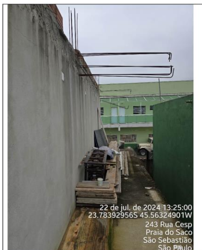
Foto 15 – fachada posterior pavimento superior
