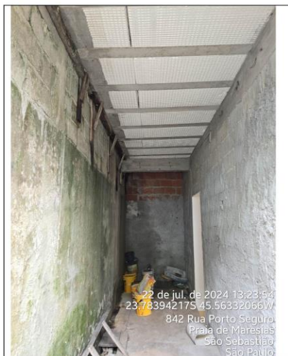
Foto 11 – corredor acesso fundos do prédio
