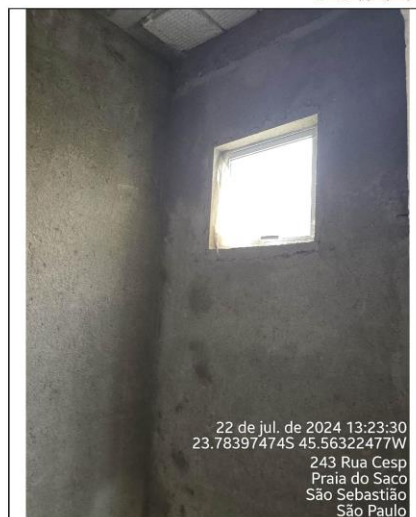
Foto 08 – ambiente provisionado para banheiro
