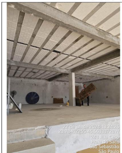
Foto 12 – vista pavimento superior
