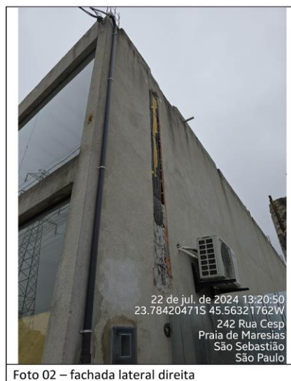
Foto 02 – fachada lateral direita
