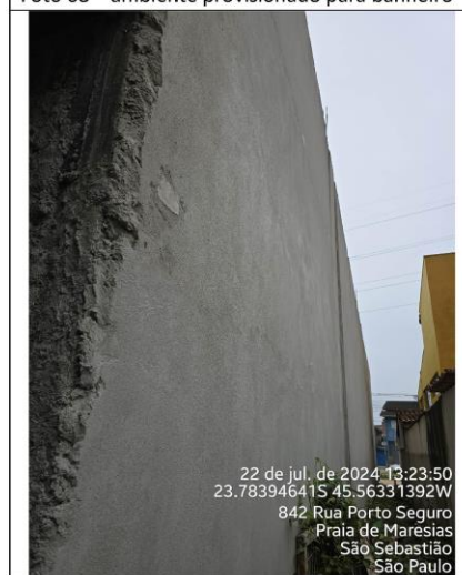
Foto 10 – fachada lateral esquerda
