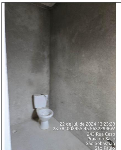
Foto 07 – ambiente provisionado para banheiro
