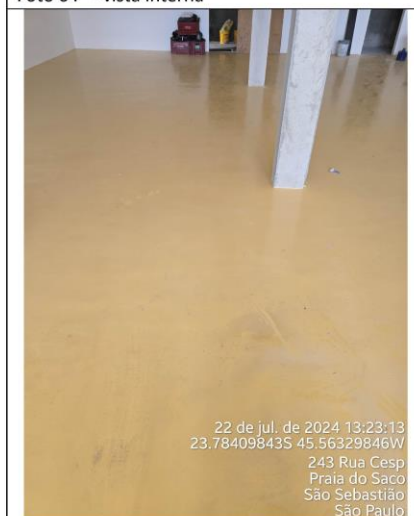
Foto 06 – piso em pintura epóxi
